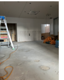
現在、救急外来拡大工事中
